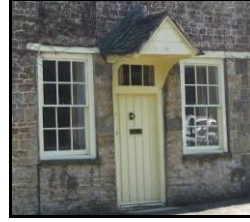
44 Sandways cottage door & windows
