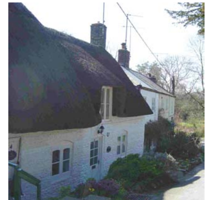
Fig 31. Nos. 4-5 Mill Lane
